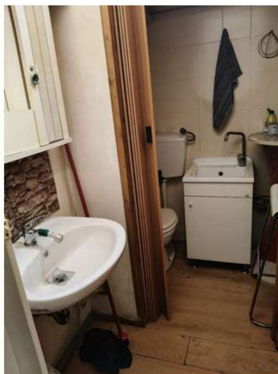
FOTO N. 38 BAGNO E ANTIBAGNO
